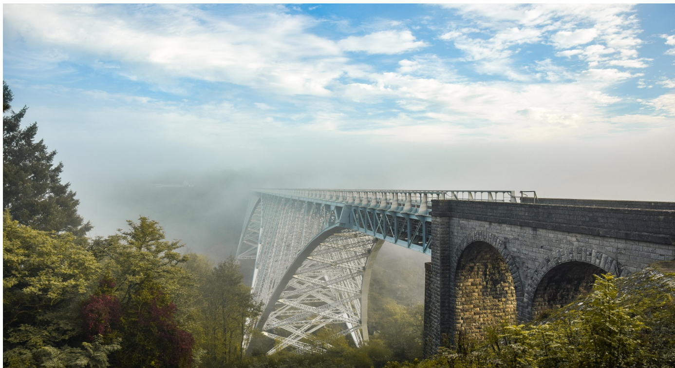
Viaduc du Vaur
