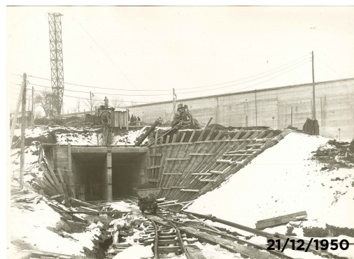
Ouverture, dans l'eau, de la conduite forcé vers St-Amans
